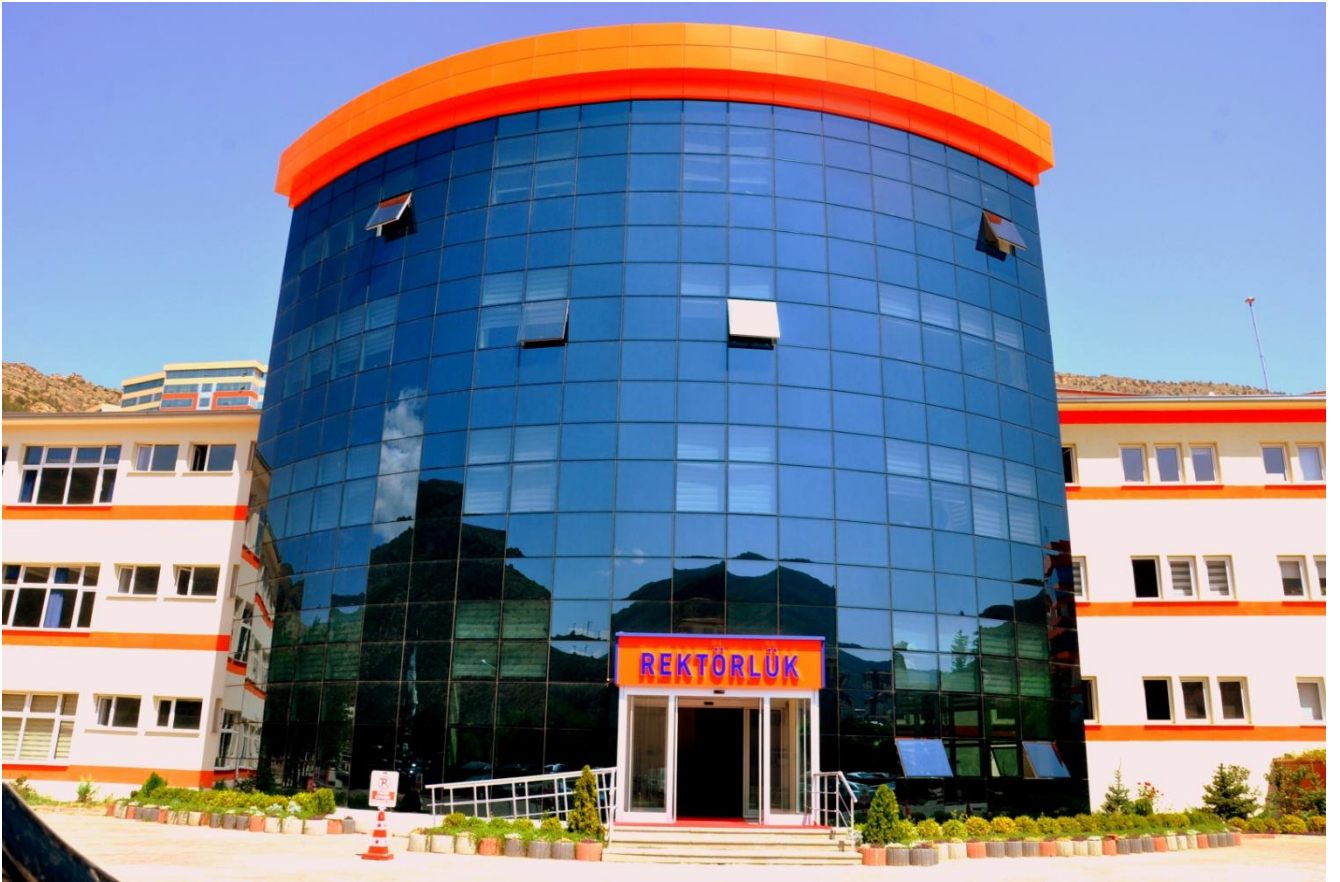
Resim 4 : Rektörlük Ek Binası
