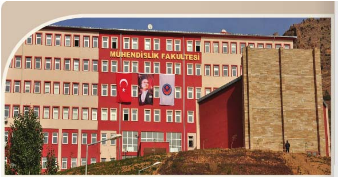
Şekil 1. Fakültemiz Hizmet Binasına Ait Bir Görünüm
